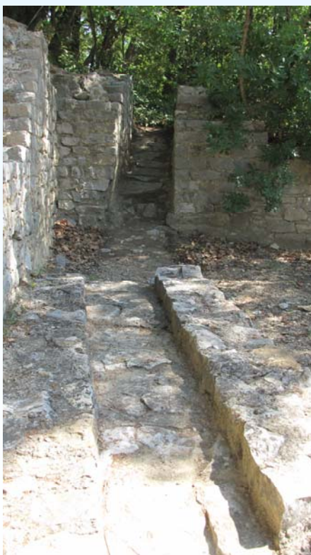
Canal d'alimentation depuis l'aqueduc
