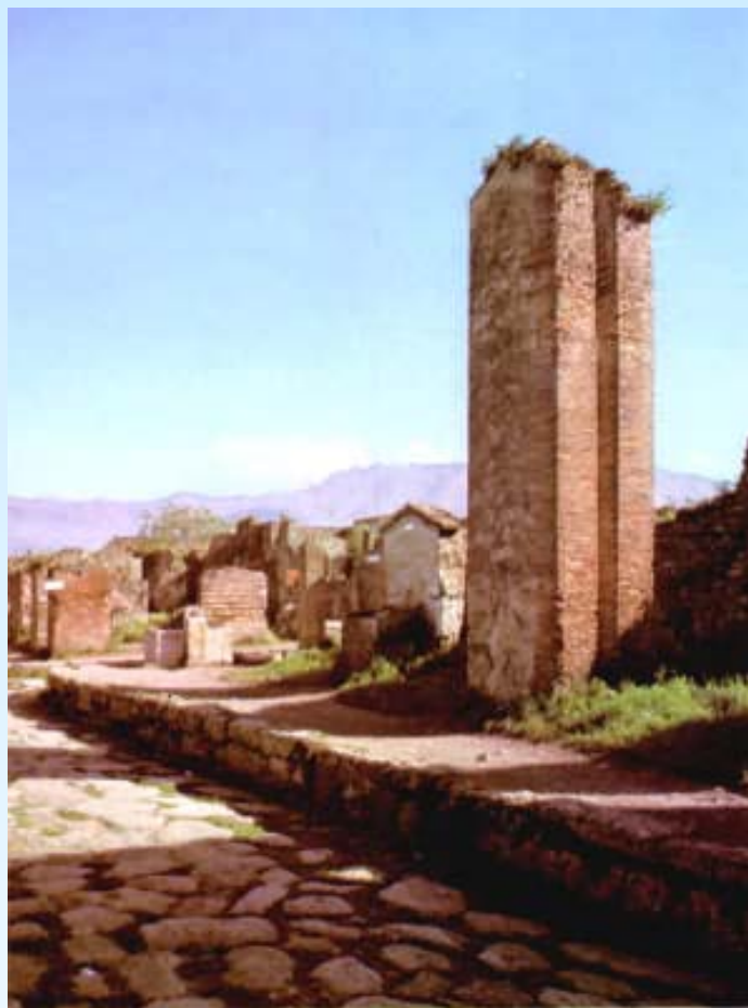
Un château d'eau à l'Est de la voie Stabania (Région VI, insula 14), alimenté par le répartiteur de la porte du Vésuve. Au fond, une fontaine.
